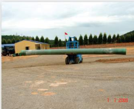
VẬN CHUYỂN ỐNG RA BÀI TẬP KẾT Transporting pipes to the gathering yard
